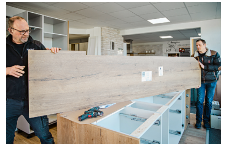
VOLLER EINSATZ Küchenstudio- besitzer Jens Oehlkers (r.) packt beim Einbau einer Arbeitsplatte mit an. Die Arbeit des Montageteams erleichtert ihm den Austausch der Ausstellungsküchen enorm.
